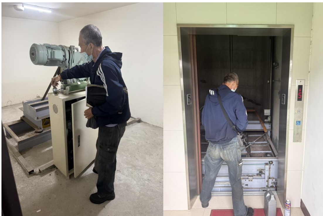
▲電梯設備在學園內是相當重要的設備，每天載運行動不便的園生上下樓外，還需運送園生們的衣物到 1 樓洗衣場進行晾曬，例行的保養工作更是不能馬虎。
