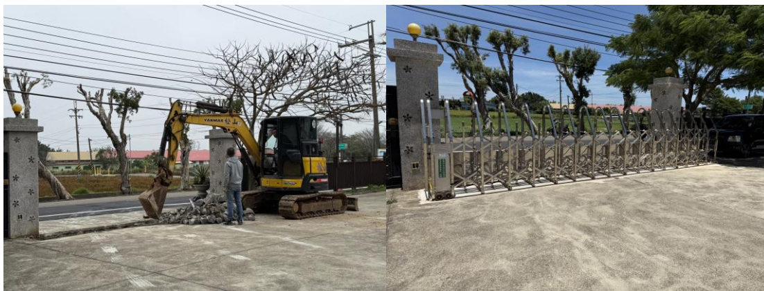
▲汰換老舊大門設備，讓電動大門能夠正常運轉，防止大門脫離軌道造成危險。
