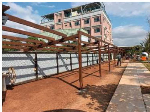
△風雨走廊及補強興建工程
