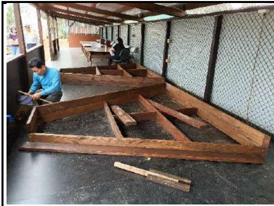
△支架施工製作中
