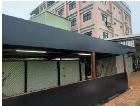
△風雨走廊及補強興建工程
