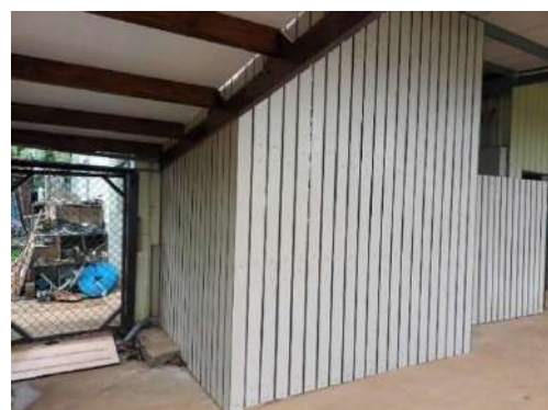
△消防基座及安全圍欄工程
