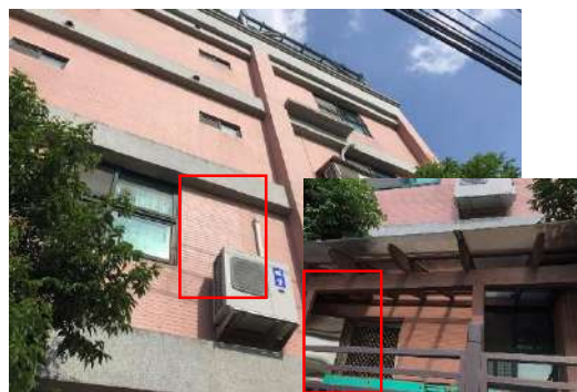
△外牆相關整修及玻璃更換
