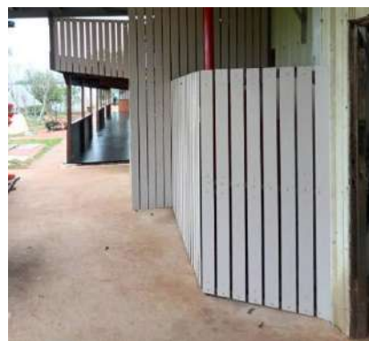
△消防基座及安全圍欄工程
