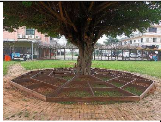
△平台施工製作中
